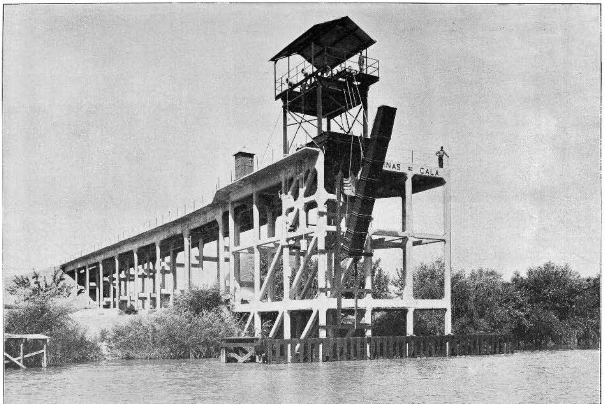
Embarcadero de hormigón armado en el Guadalquivir.—Segundo viaducto y embarcadero.
