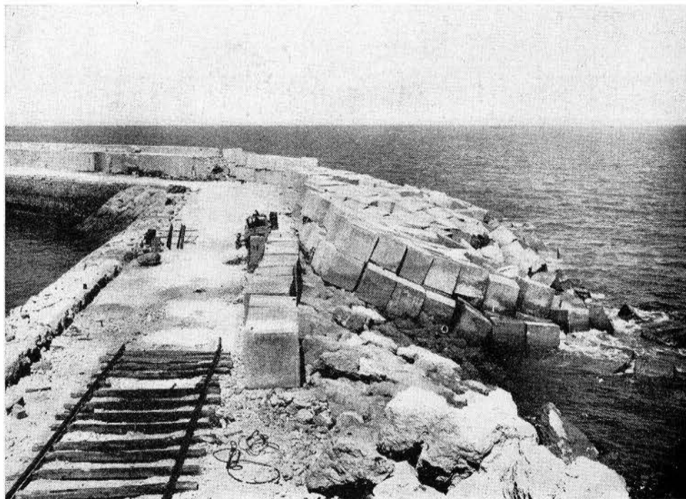
Detalle del manto principal de bloques de hormigón.
