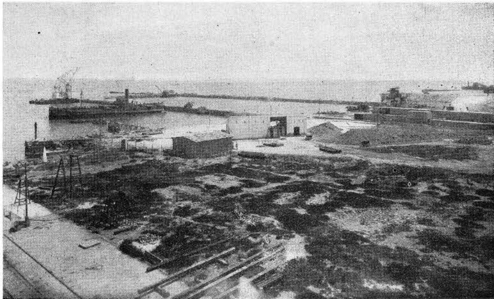
Vista, desde el dique seco, del muelle en construcción y taller de bloques.
