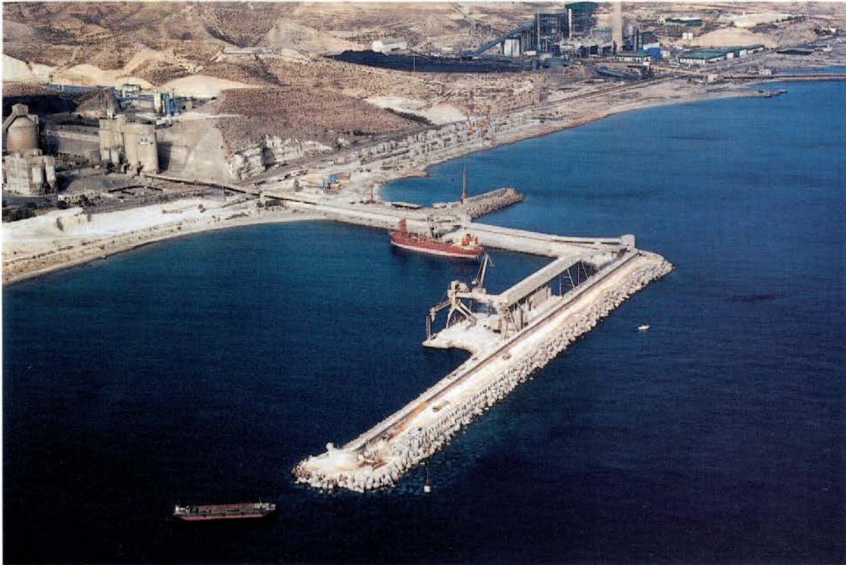
Dique Hisalba. Casi finalizada la obra.
