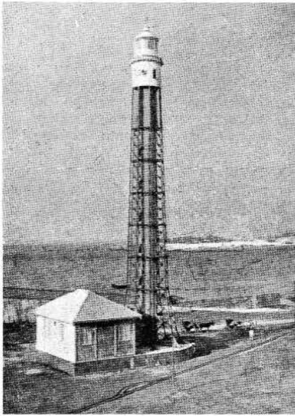
Fig. 11.—Faro eléctrico de Cádiz. Apariencia: grupo de dos destellos relámpagos blancos cada 10 segundos. Altura del plano focal sobre el nivel del mar, 40,44 m. Alcance aproximado, 32 millas.
