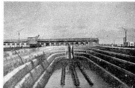
Fig. 14.—La Carraca. Dique seco.
