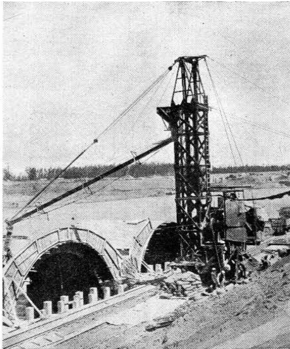
Parte posterior del muelle Alfonso XIII, en construcción.
