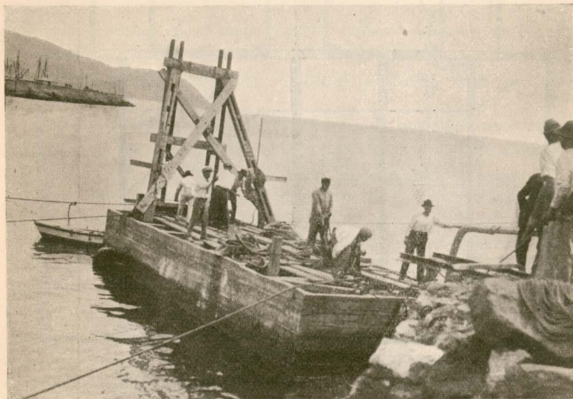
Fig. 204. Fondeo de un cajón en Santa Cruz de Tenerife.
