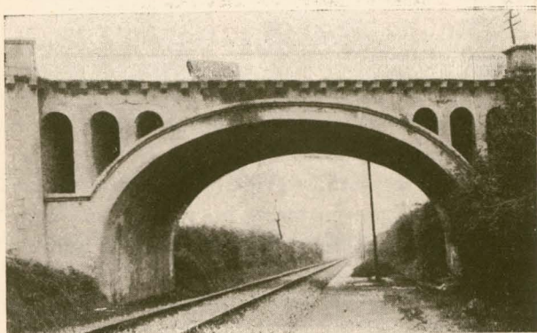
Fig. 195. Paso superior para la carretera de Gijón a Musel.
