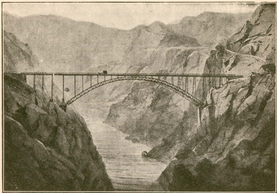
Fig. 40. Puente-viaducto de Pino, sobre el Duero
