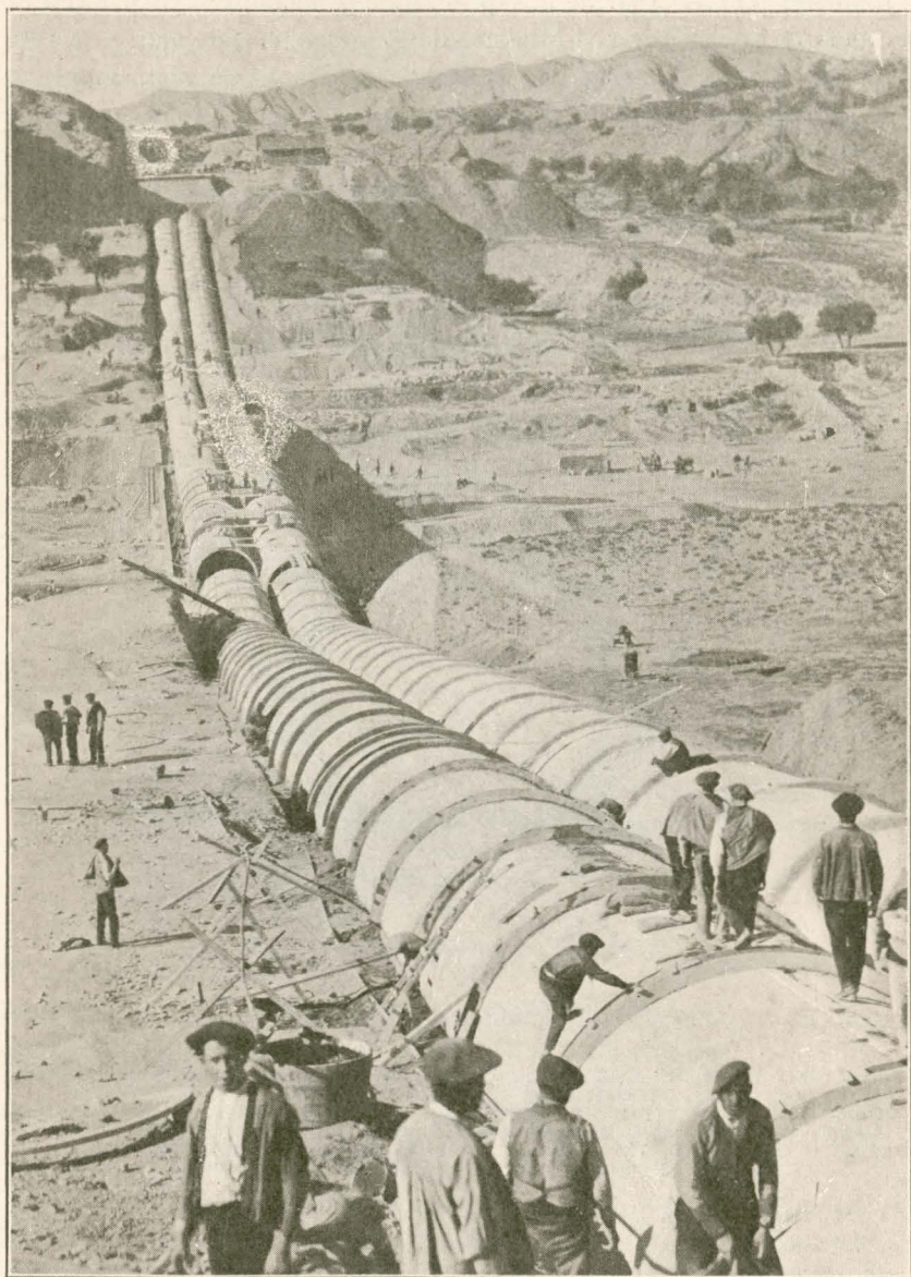
Fig. 321.—Construcción del sifón del Sosa, y Ribabona.
