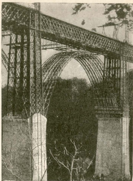
Fig. 261.—Armaduras rígidas para los arcos.
