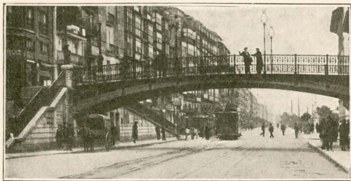
Fig. 281.—Pasarela en Santander.
